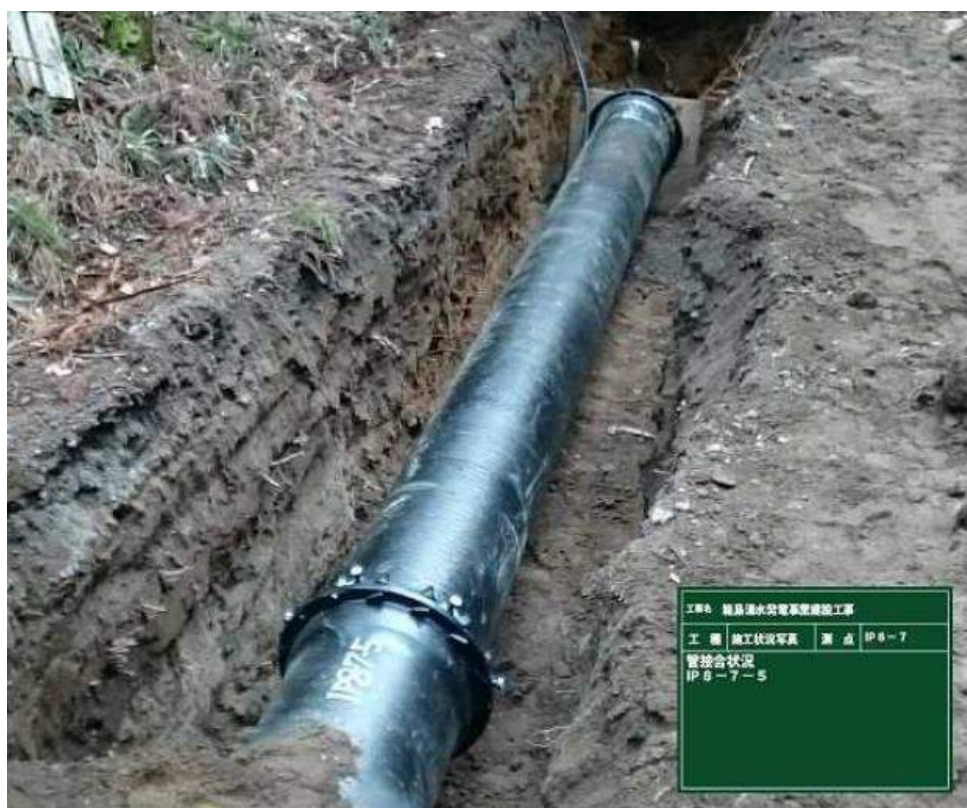
写真4◇導水管の埋設工事。出典：東吾妻町役場
