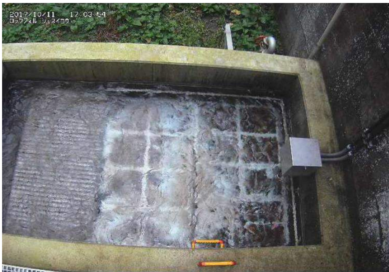
写真 7◇取水口の映像も遠隔監視システムの画面に表示。出典：東吾妻町役場
