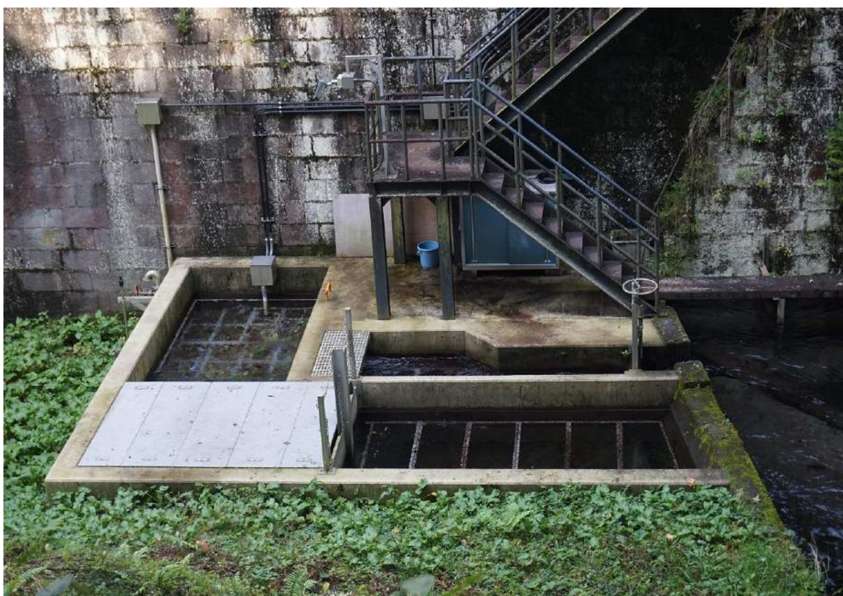
写真8◇湧水口から取水口までの水の流れ（上）、3つの水槽で構成する取水口（下）
