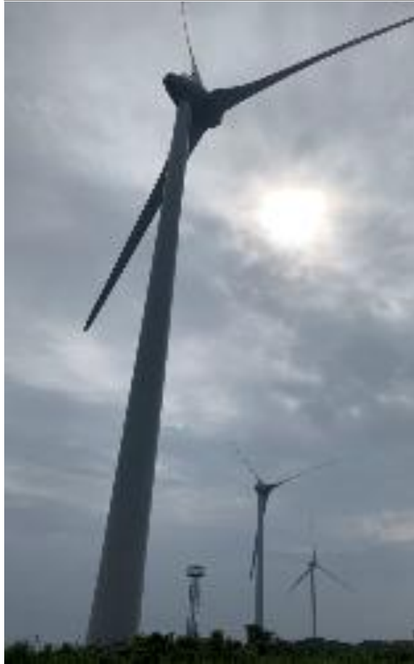
長崎県松島 Enercon 2,300kW x 3基
