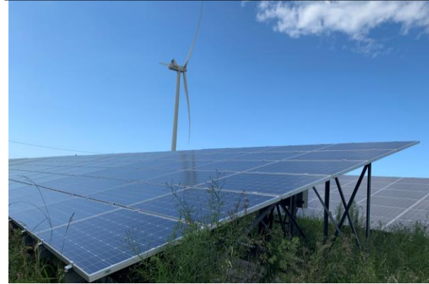
福岡県北九州市 Vestas 3,300kW x 2基
