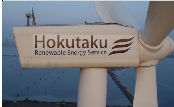
福岡県北九州市 Vestas 1,990kW x 1基
