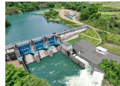
支援を受け建設中の 「湯の瀬いとおしき発電所」完成予想図
