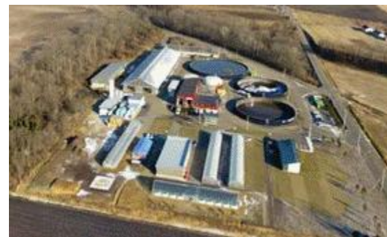
中鹿追バイオガスプラント (鹿追町資料より)
