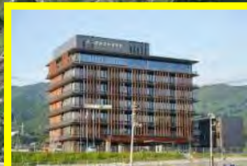
公共施設に電力供給
