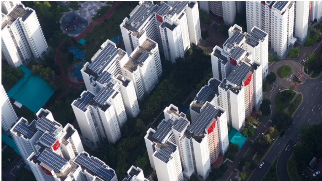
写真 4. シンガポールの屋上太陽光発電プロジェクト。出典：Apple
