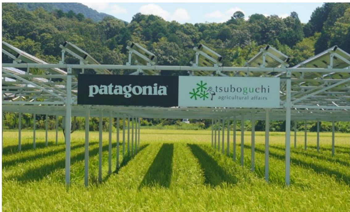
写真 4◇Patagonia と連携する水稻のソーラーシェアリング(5 号機)
