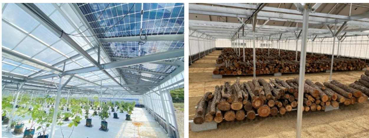
写真 3◇アグリソーラーハウスの内部(左:遮光率 30%、右:同 50%)
