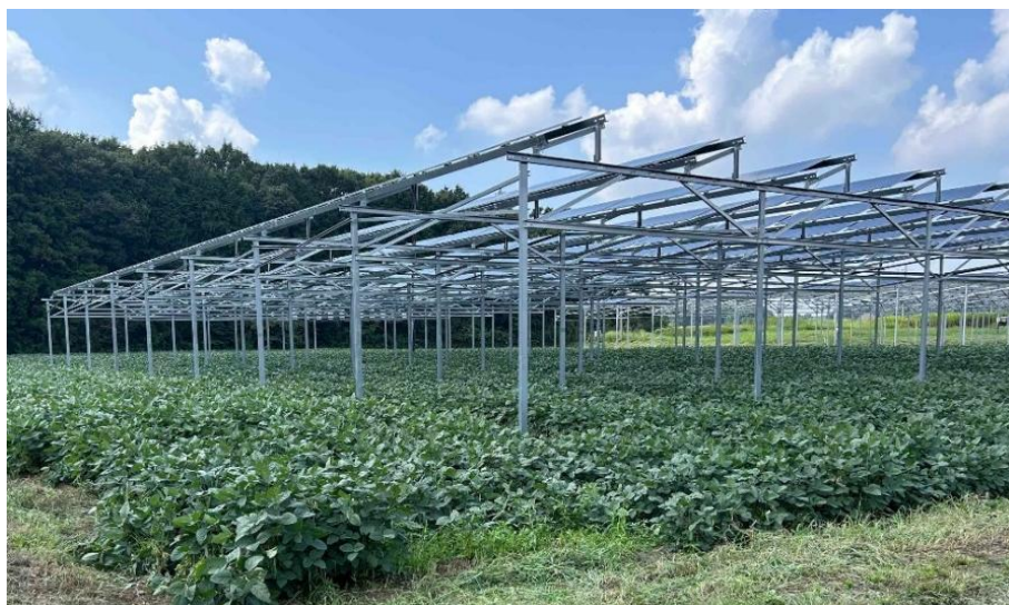
写真1◇ソーラーシェアリングによる大豆の栽培(芳賀町)
