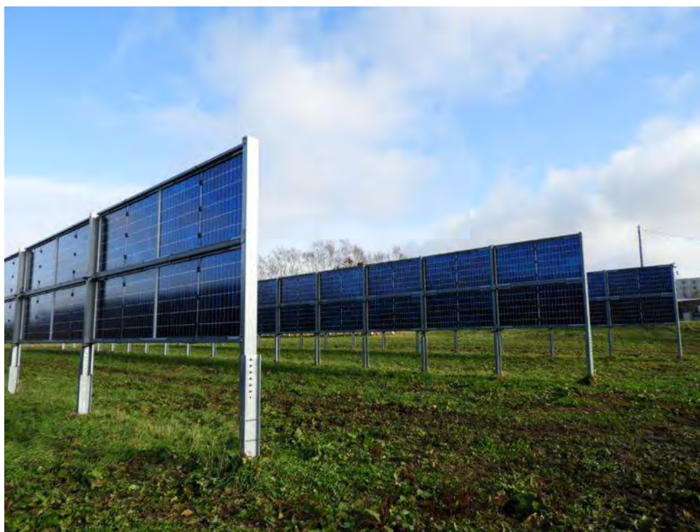
写真 3-11 垂直設置型の太陽光パネルで牧草を栽培
