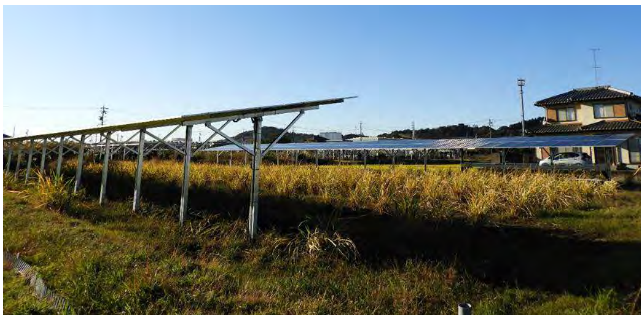
写真 3-10 一本足の架台を設置した農地でマコモダケを栽培
