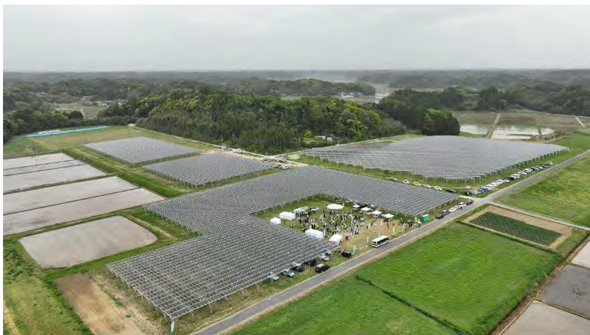
写真1-4 「匝瑳おひさま発電所」の全景
