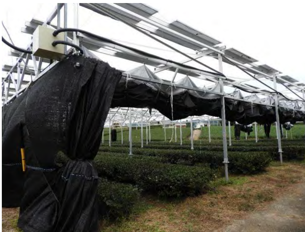
写真 3-5 碾茶の栽培に必要な被覆のための棚の役割を架台が担う
