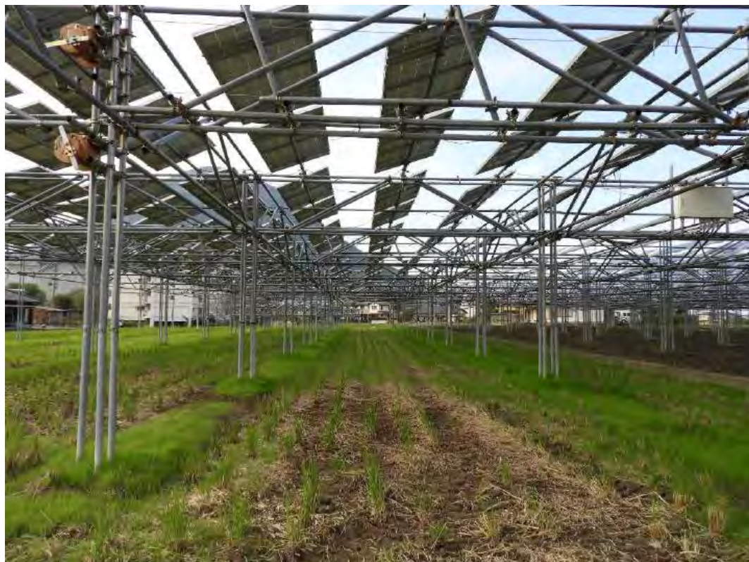
写真 3-1 水田に設置した可動式の太陽光パネル
