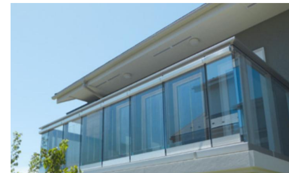
パナソニック (バルコニーに設置、建材一体型)
