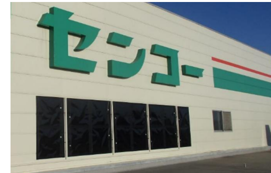
センコー (壁面に設置)
