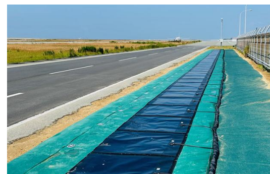
神戸空港 (滑走路の脇に設置)
