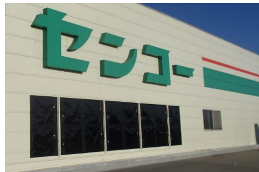
センコー (壁面に設置したペロブスカイト太陽電池)
