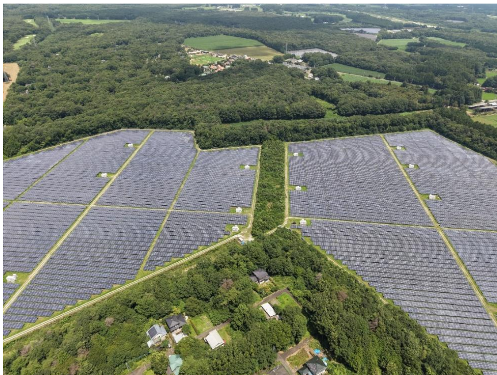
写真 5 那須塩原ソーラー発電所
