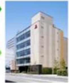
新本社ビル(需要場所) シナネン ホールディングス 株式会社
