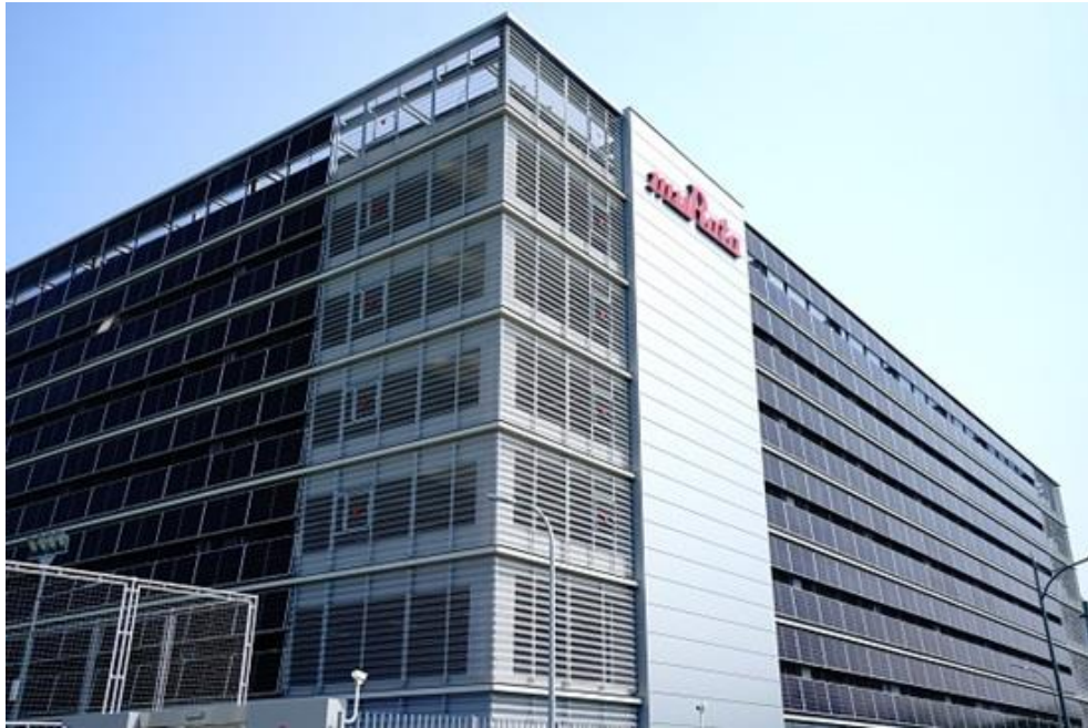
写真 5. 両面発電の太陽光パネルを採用した立体駐車場（無錫村田電子、江蘇省無錫市）
