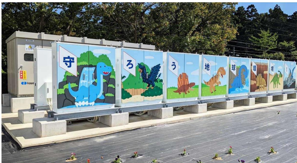
写真 3. 金津村田製作所の蓄電池システム。福井県にちなんで恐竜のイラストで装飾
