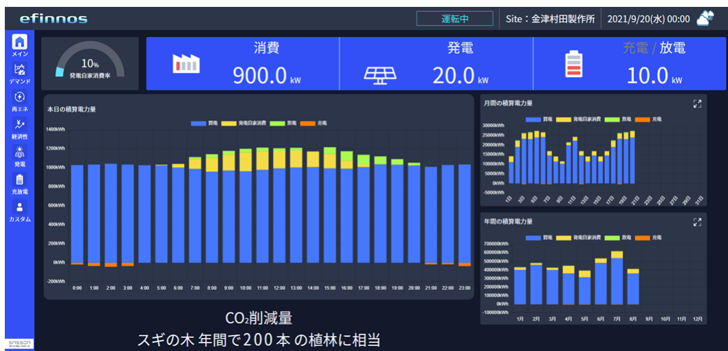
写真 4. エネルギー管理システムの画面
