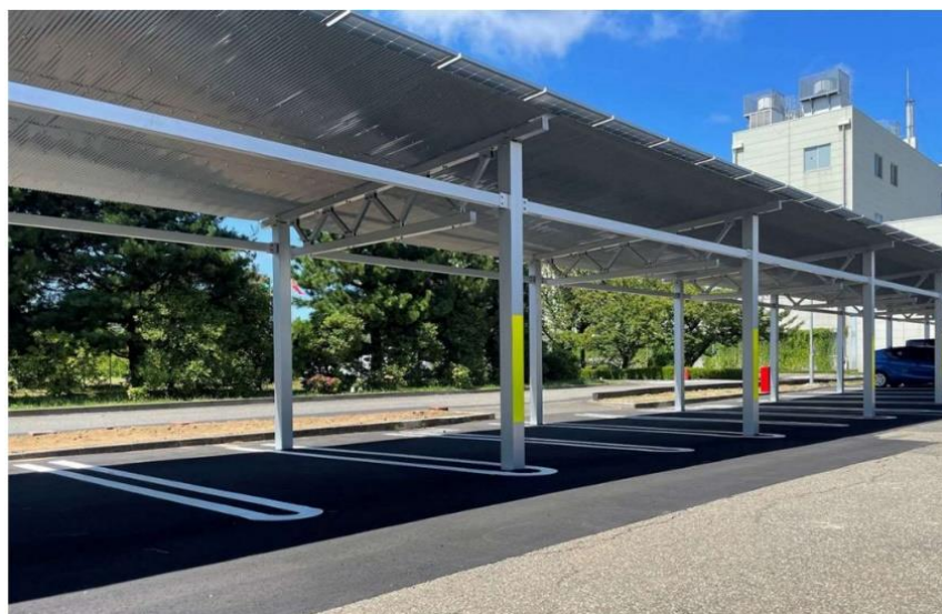
写真 2. カーポート型の太陽光発電システムの構造
