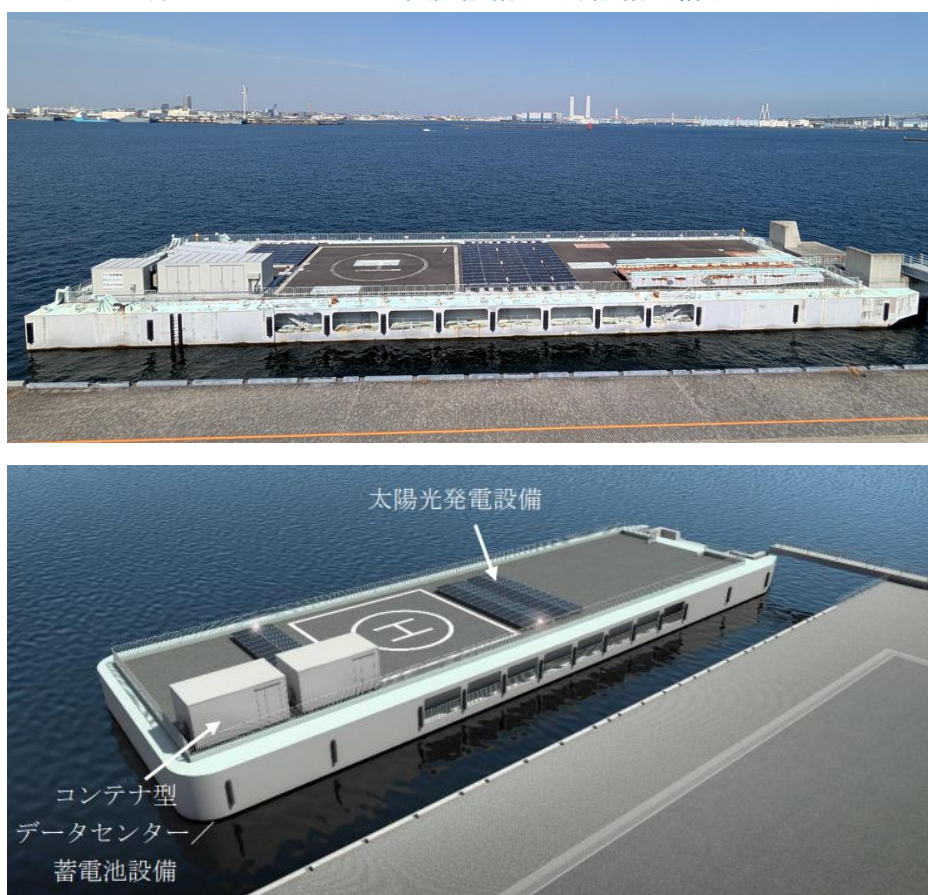
図 14. 洋上データセンターの実証設備(上)、設備の構成イメージ(下)
