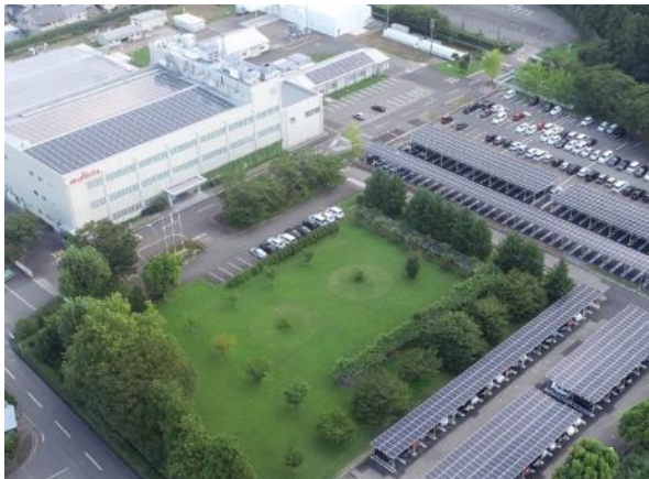
金津村田製作所 クリーンエネパーク
