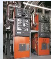
木質バイオマスボイラー 2012年3月稼働見込
