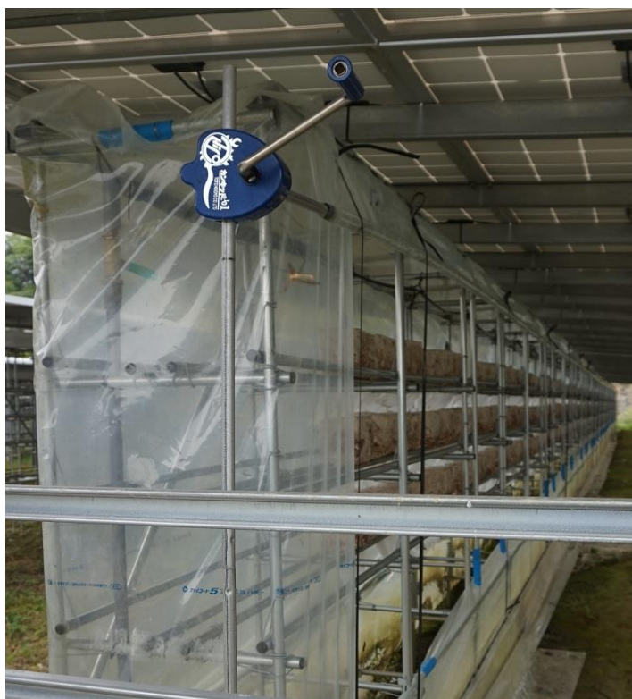
写真10◇保温・保湿のためにカーテンを下げた状態（上）。カーテンは手動で巻き上げる（右）。
