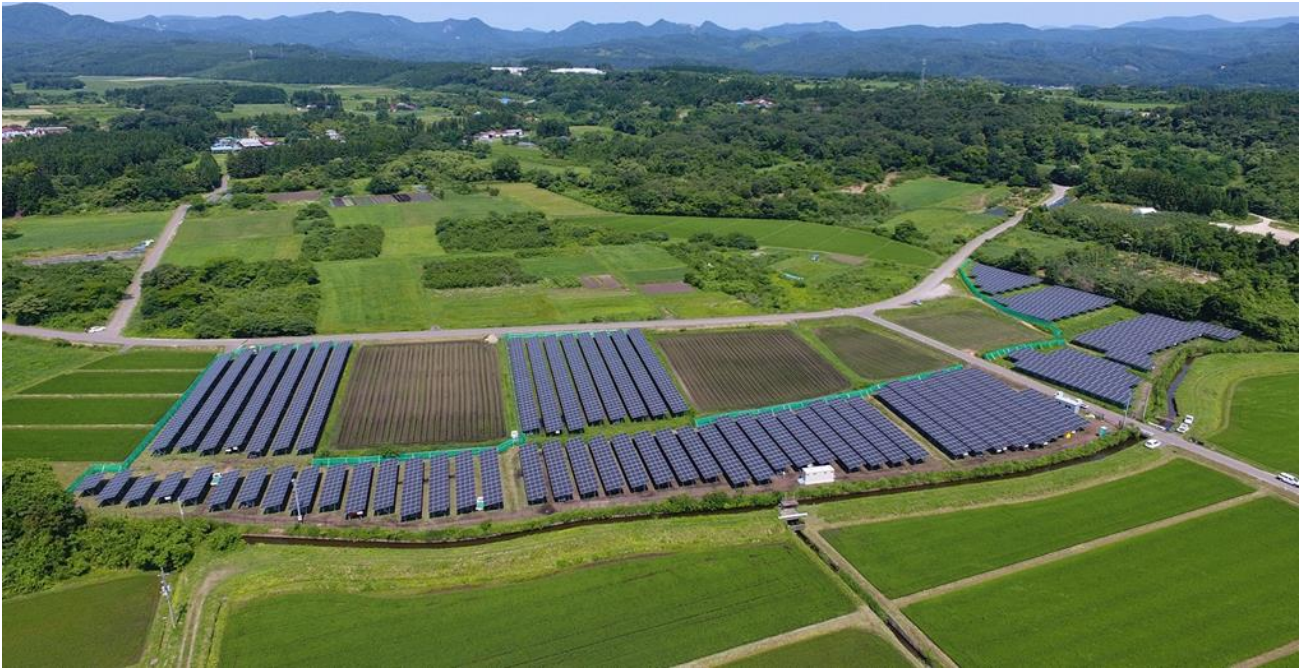
写真 4◇加美町の農地に建設した「加美八幡堂太陽光発電所」の全景 太陽光パネルが並んでいる区画だけが対象の農地。出典：サステナジー
