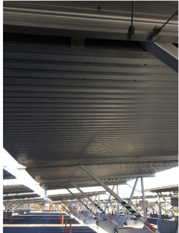
写真 6◇接続箱からの構内ケーブル（左）、パネル裏のカバー（右）
