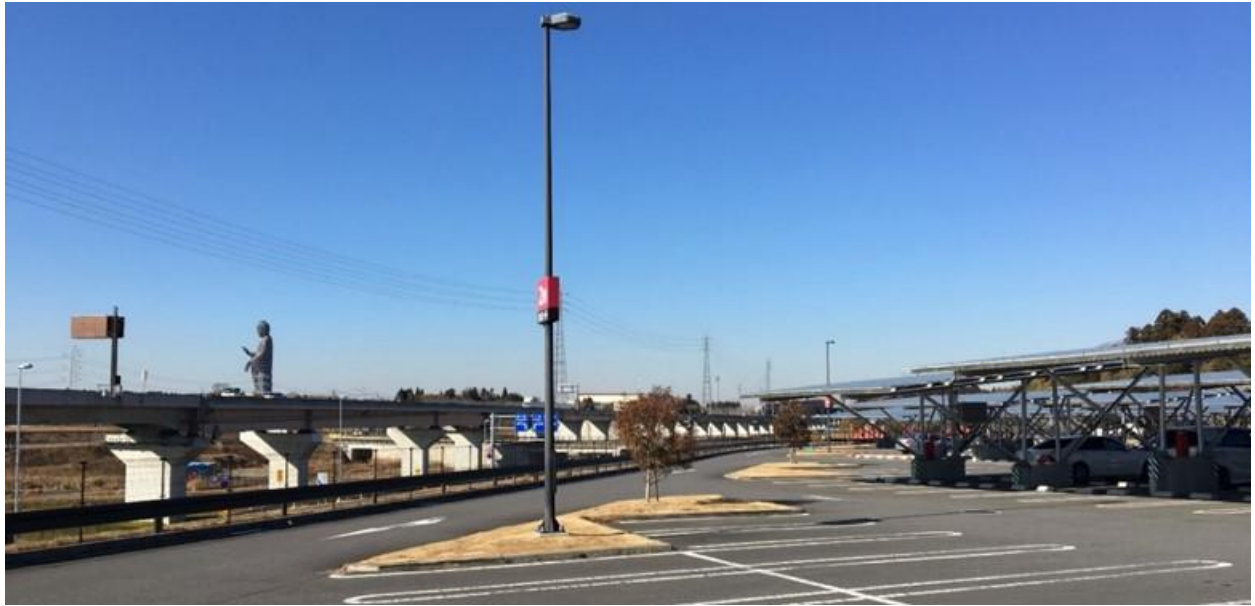
写真 5◇第 2 駐車場の付近を通る高速道路（写真左の高架橋部分）
