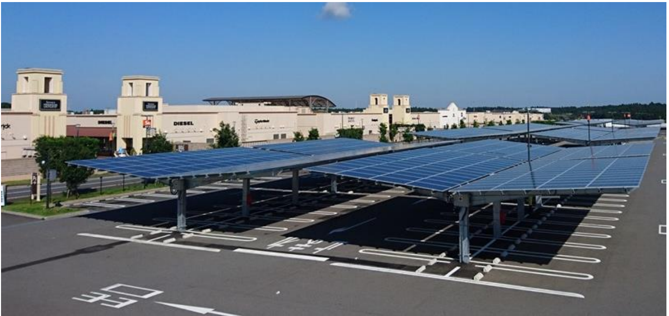
写真 9◇酒々井プレミアム・アウトレットに完成した新型 SCP。東西対向 2 列タイプを採用。
