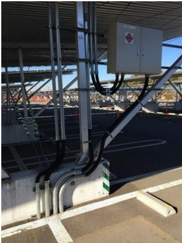
写真 6◇接続箱からの構内ケーブル（左）、パネル裏のカバー（右）
