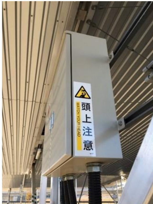
写真 3◇架台の筋交い部分（左）や接続箱（右）に貼った注意書き
