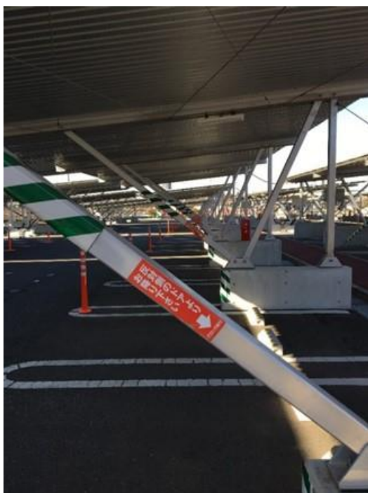
写真 3◇架台の筋交い部分（左）や接続箱（右）に貼った注意書き
